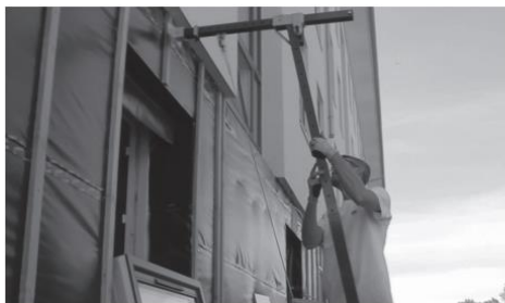
Lyftkroken på den elektriska fönsterlyften hängs i jibben.
