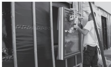
Lyft av fönster med jibb.
