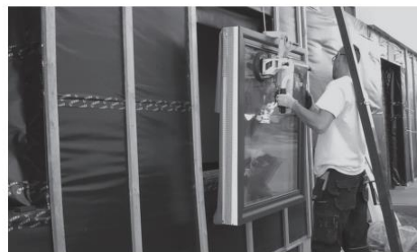
Vinduet løftes trygt opp og monteres raskt, enkelt og uten tunge løft.
