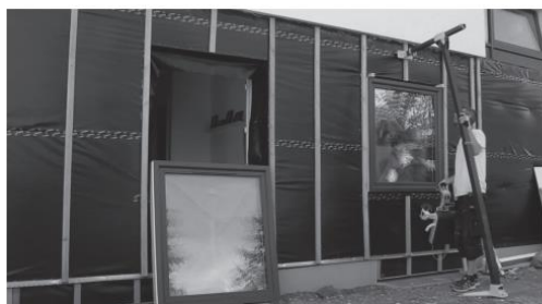
Et typisk scenario ved vindusbytte på en enebolig.
