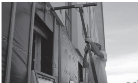
Løftekroken på den elektriske vindusløfteren henges enkelt i jibben.
