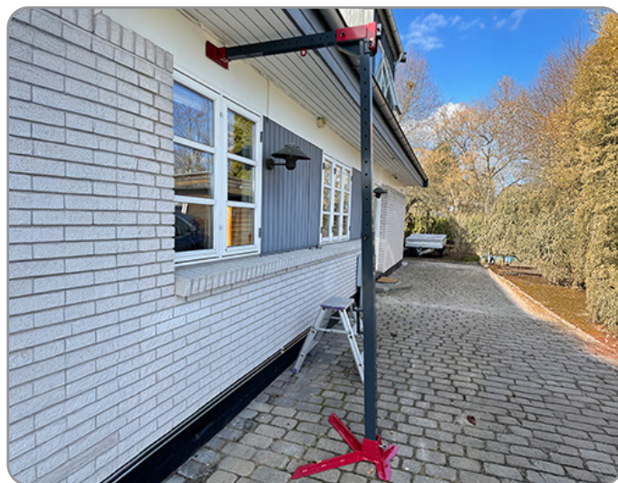
Jigg til vinduesudskiftning ved fx énplanshuse. Løftekrogen på den elektriske vinduesløfter hænges direkte i jigg.
