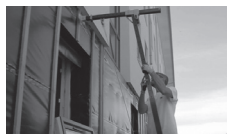
UPCLIMBER JIB kræver minimalt plads over vinduesåbningen
